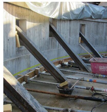
Aussparungen um die Abstützungen der Rühlwand
